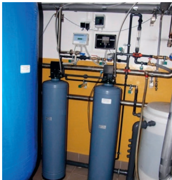
Fot. 1. nerka wody chłodniczej dla skraplacza amoniaku o mocy 2,3 MW
